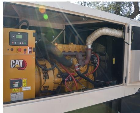
*Un nuevo grupo electrógeno Cat® GC D200 es la última incorporación a una flotilla de otros cuatro grupos electrógenos Cat que proporcionan energía de reserva a las operaciones en Natural Bridge Caverns.*
